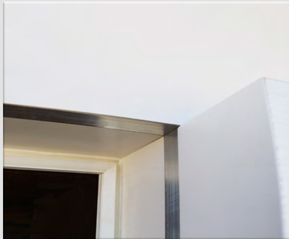
Wandbündig offen, verdecktliegende Stahlzarge
